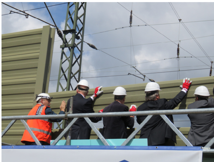
Foto 2: Einfügung letztes Wandelement zum Bauende Mai 2019
